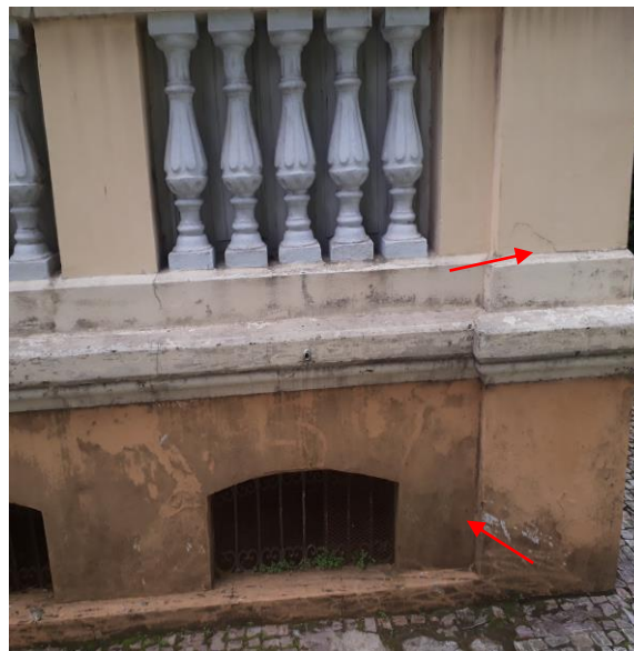
Foto 29 – Mancha de umidade e fissura de retração.
