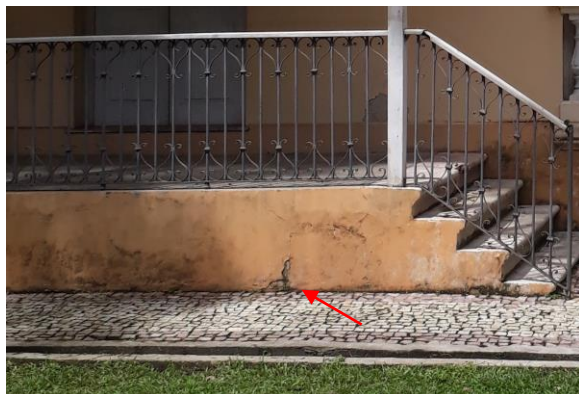
Foto 1 – Mancha de umidade e fissuras de retração.
