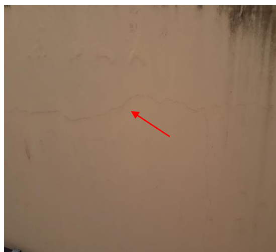
Foto 11 – Fissura de retração.
