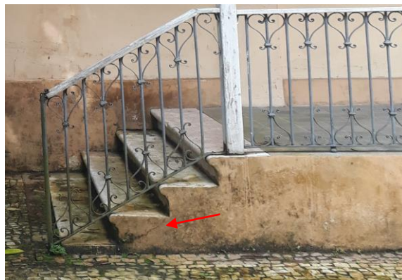
Foto 2 – Mancha de umidade e fissuras de retração.
