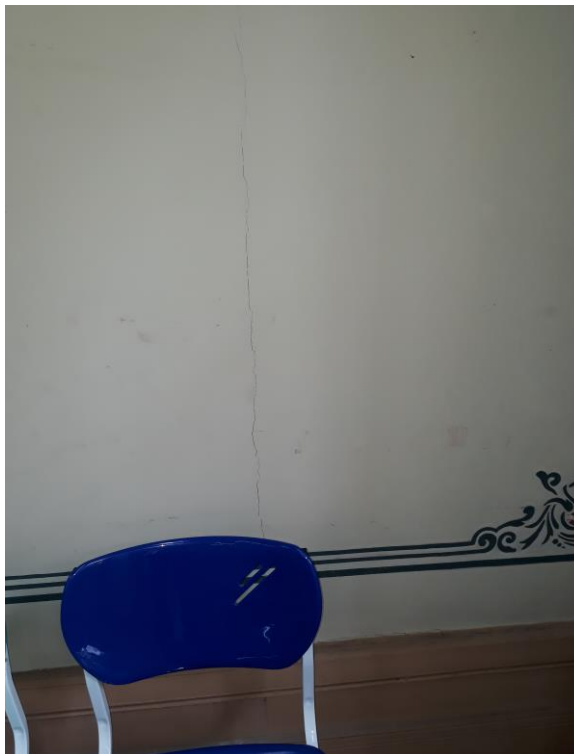
Foto 25 – Trinca na parede.
