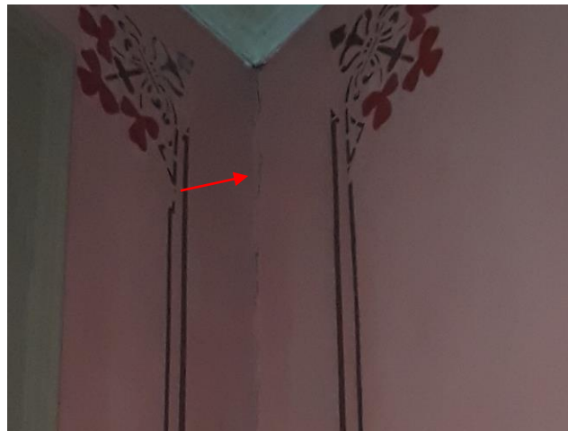
Foto 27 – Rachadura de descolamento
