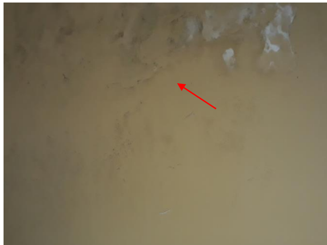
Foto 6 – Mancha de umidade e reboco solto.
