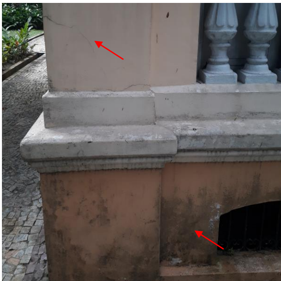
Foto 28 – Mancha de umidade e fissura de retração.
