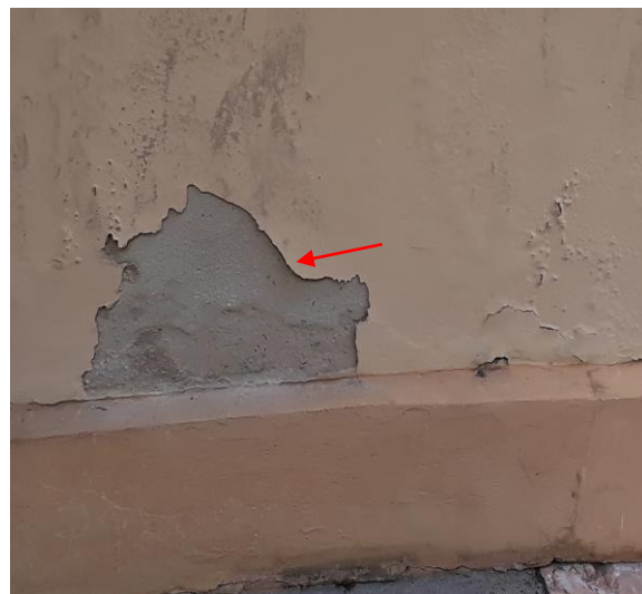
Foto 4 – Mancha de umidade e reboco solto.
