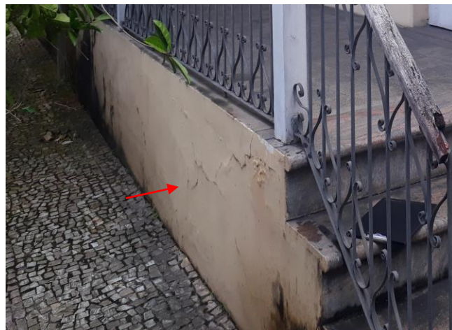
Foto 15 – Fissura de retração.
