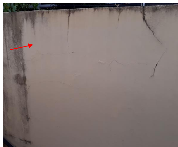
Foto 19 – Fissura de retração.
