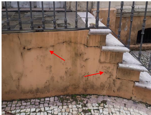
Foto 31 – Fissura de retração.
