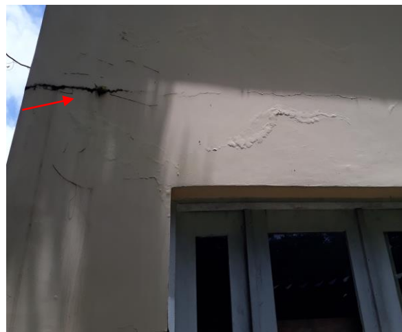
Foto 17 – Fissura de retração.
