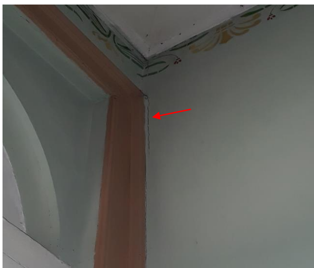
Foto 7 – Rachadura entre ligações entre paredes.
