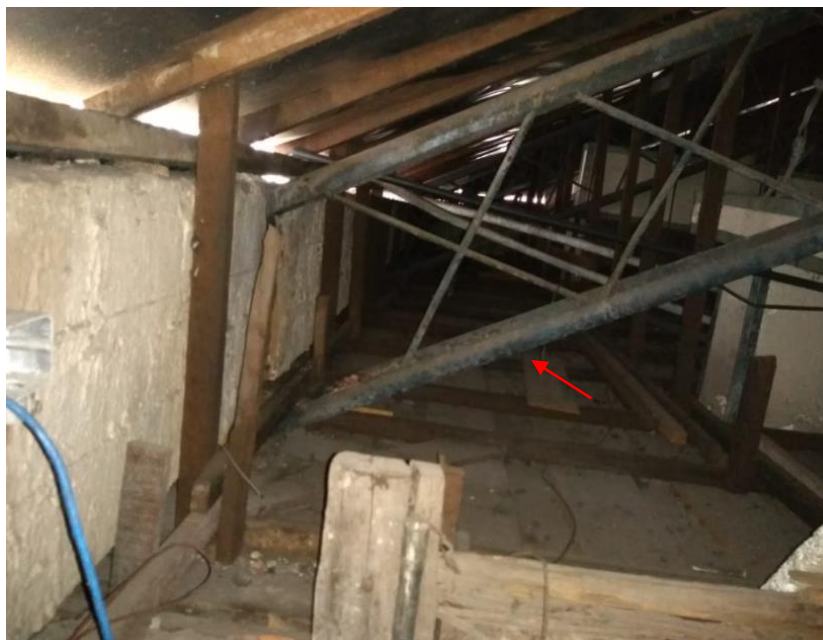
Foto 23 – Detalhe do apoio da estrutura metálica da cobertura na estrutura de concreto existente.
