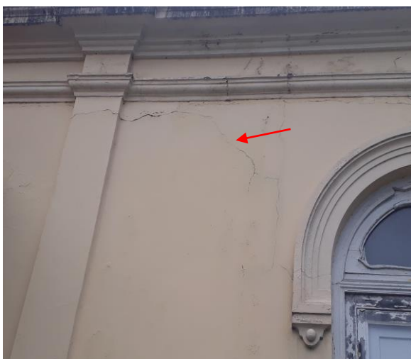
Foto 12 – Fissura de retração.
