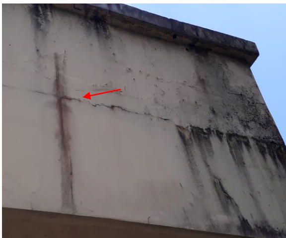
Foto 8 - Fissura na platibanda.
