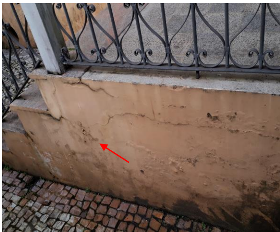
Foto 14 – Trinca de retração.
