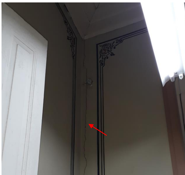
Foto 22 – Fenda na parede.
