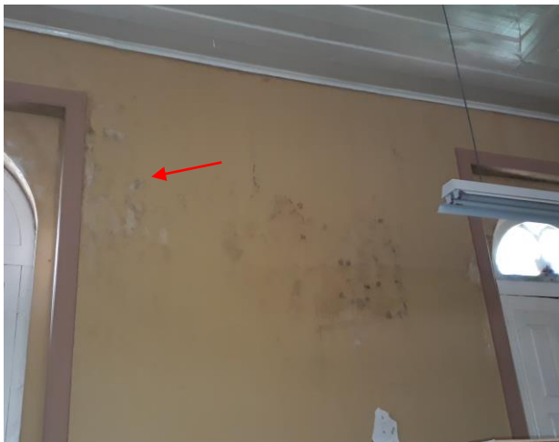
Foto 5 - Fissura no vértice do vão de janela.
