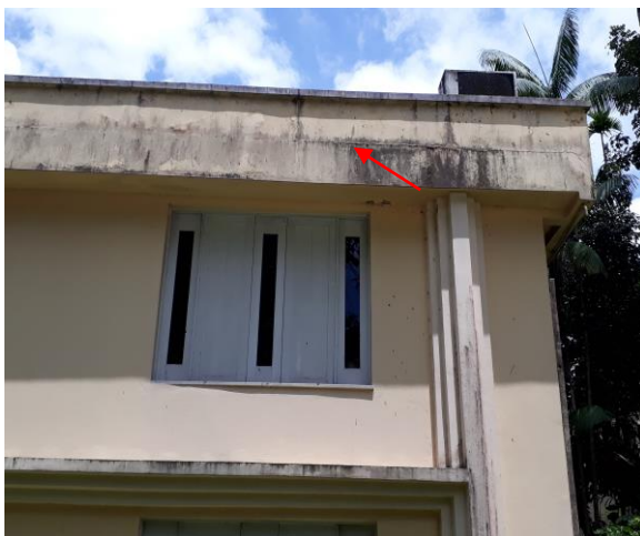
Foto 16 – Rachadura de retração.
