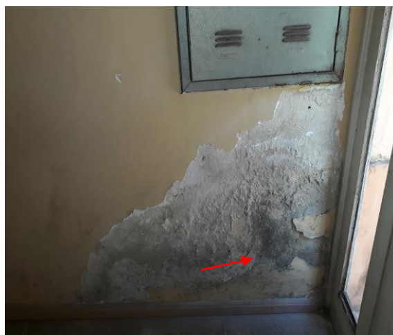
Foto 21 – Mancha de umidade e reboco solto.
