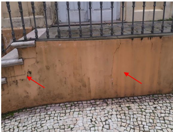
Foto 30 – Fissura de retração.
